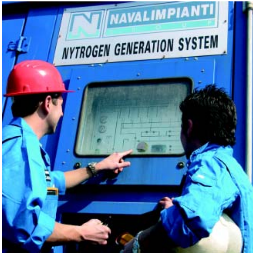
Navalimpianti Tecnimpianti Technicians checking operations
